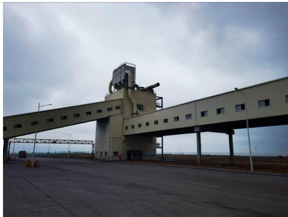
1#转运站及栈桥
