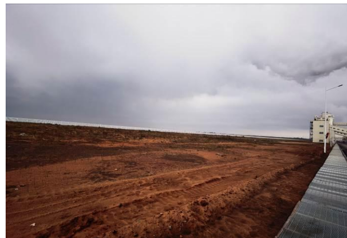
新建配煤仓等拟建场地现状
