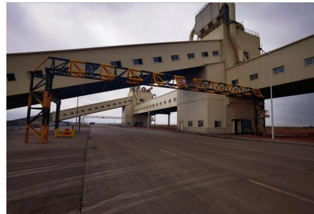
2#转运站及栈桥
