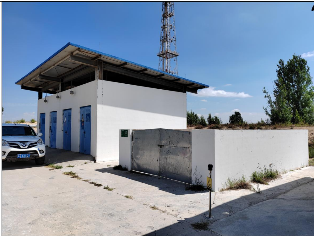
图 2-2 厂区闲置库房
