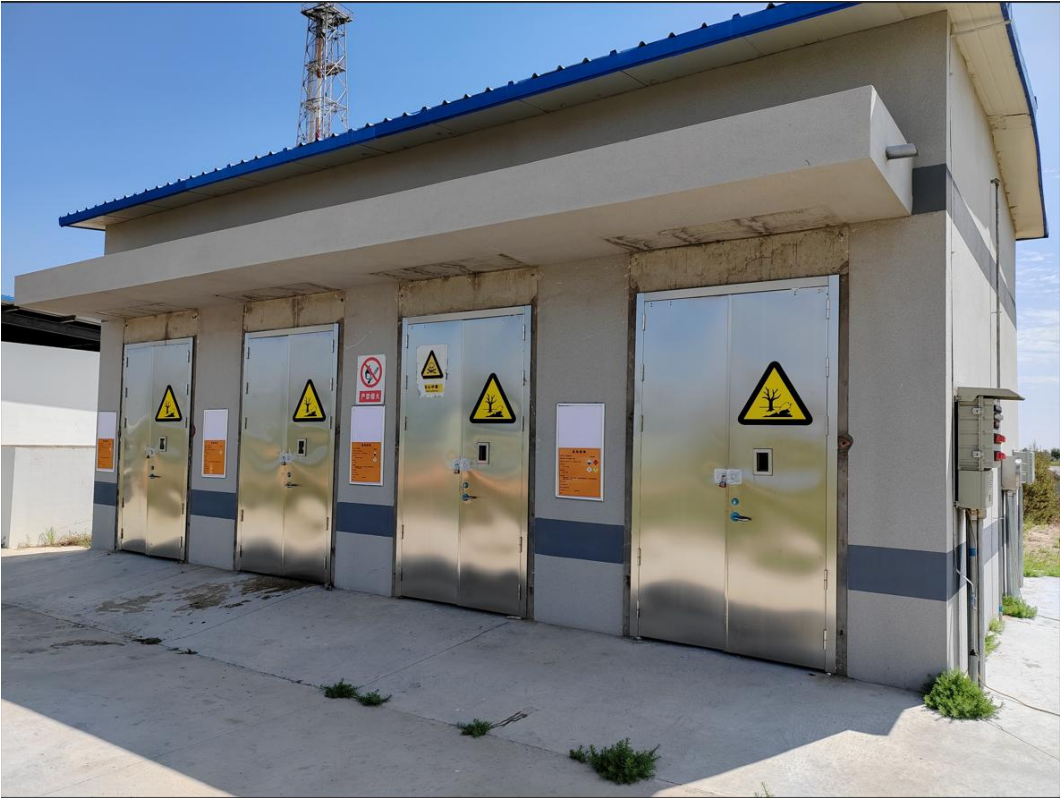
图 2-1 厂区现有危废库
