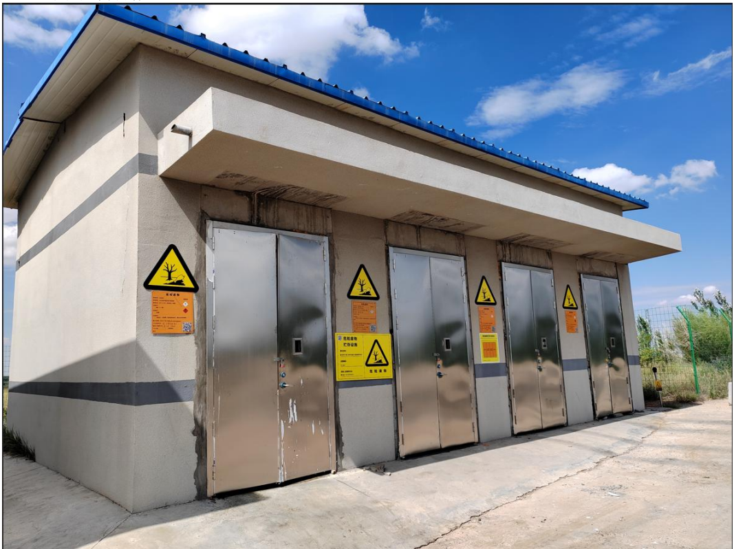
图 2-1 厂区现有危废库
