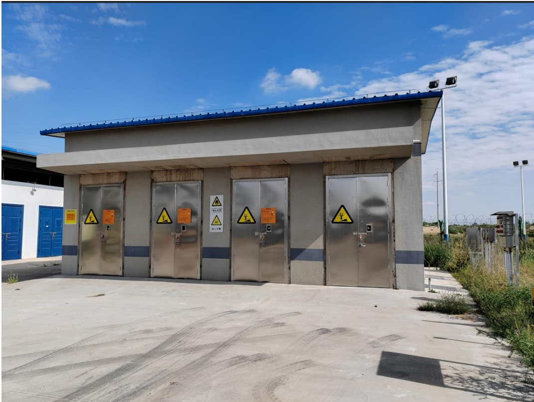
图 2-1 厂区现有危废库
