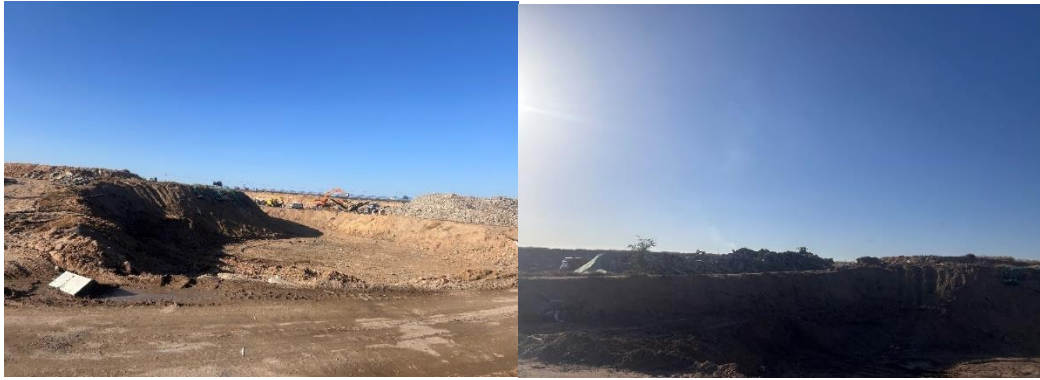
图3-2 嘎鲁图镇建筑垃圾临时处理厂现状图
